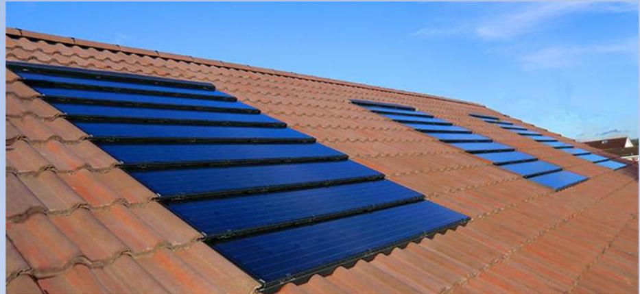
In alcuni casi i moduli fotovoltaici hanno la lunghezza dei singoli elementi del manto di copertura in altri hanno **la stessa forma** dell'elemento di copertura
