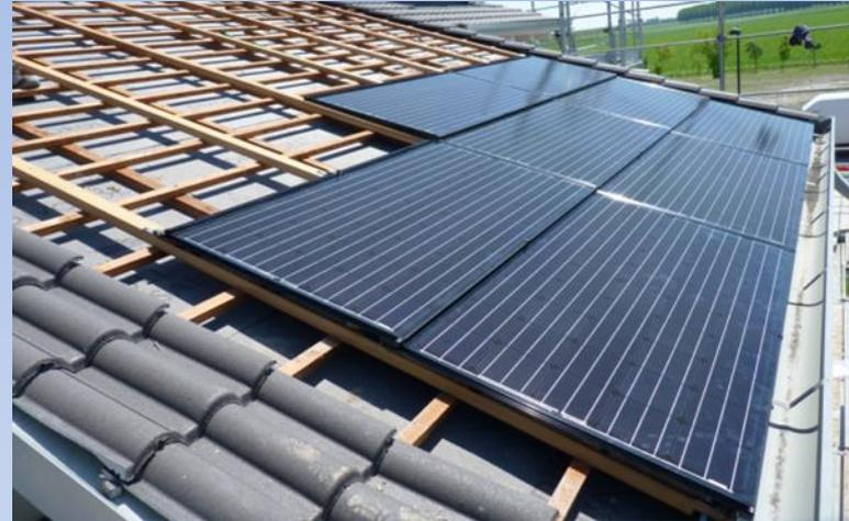
Con apposite lattonerie si raccorda l'impianto al resto del manto di copertura compresa la griglia di ventilazione
