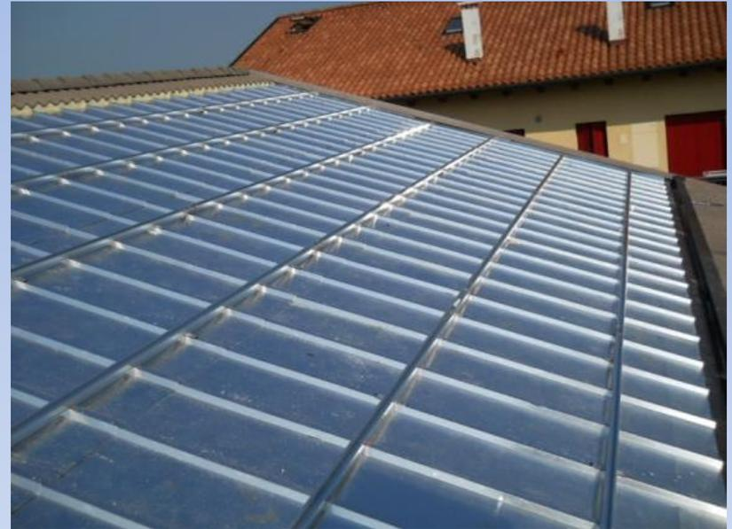
**C** - Posizionamento e fissaggio dei moduli fotovoltaici
