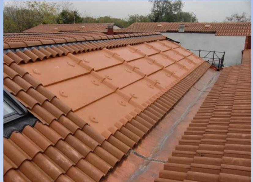
Una soluzione alternativa alla realizzazione della «vasca» in alluminio è l'inserimento di elementi di copertura sagomati al fine di posizionare i moduli fotovoltaici.
